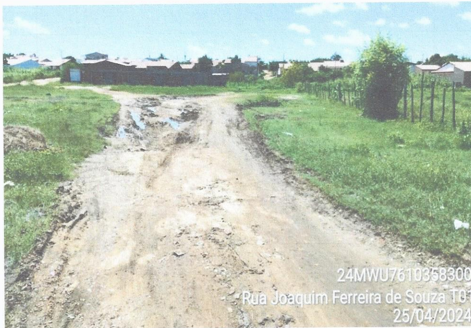
Foto 04 – Final da Rua Joaquim Ferreira de Souza (Trecho 01)
