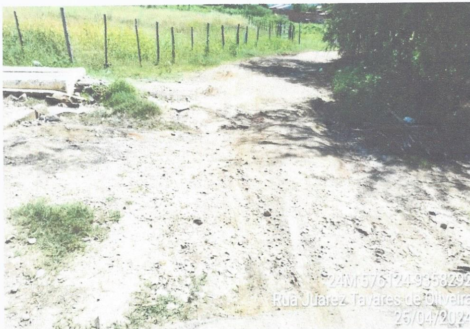
Foto 02 – Final da Rua Juarez Tavares de Oliveira
