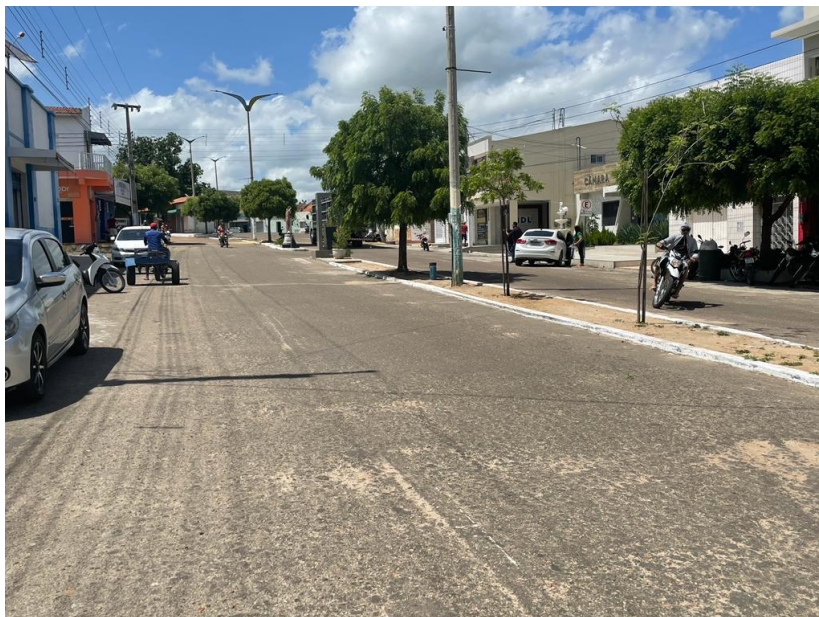
Imagem 01: Trecho em Pavimentação Asfáltica da Rua Gervásio Holanda Guerra.
